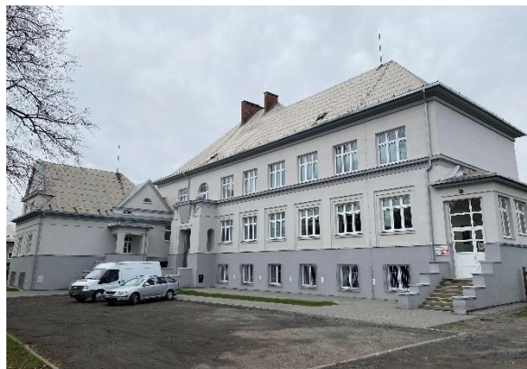
Depozitář v budově na ul. Tovární
